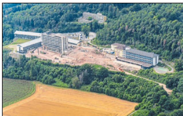
Ein Blick auf die Weserberglandklinik am Rande von Höxter. Der Abriss läuft.
