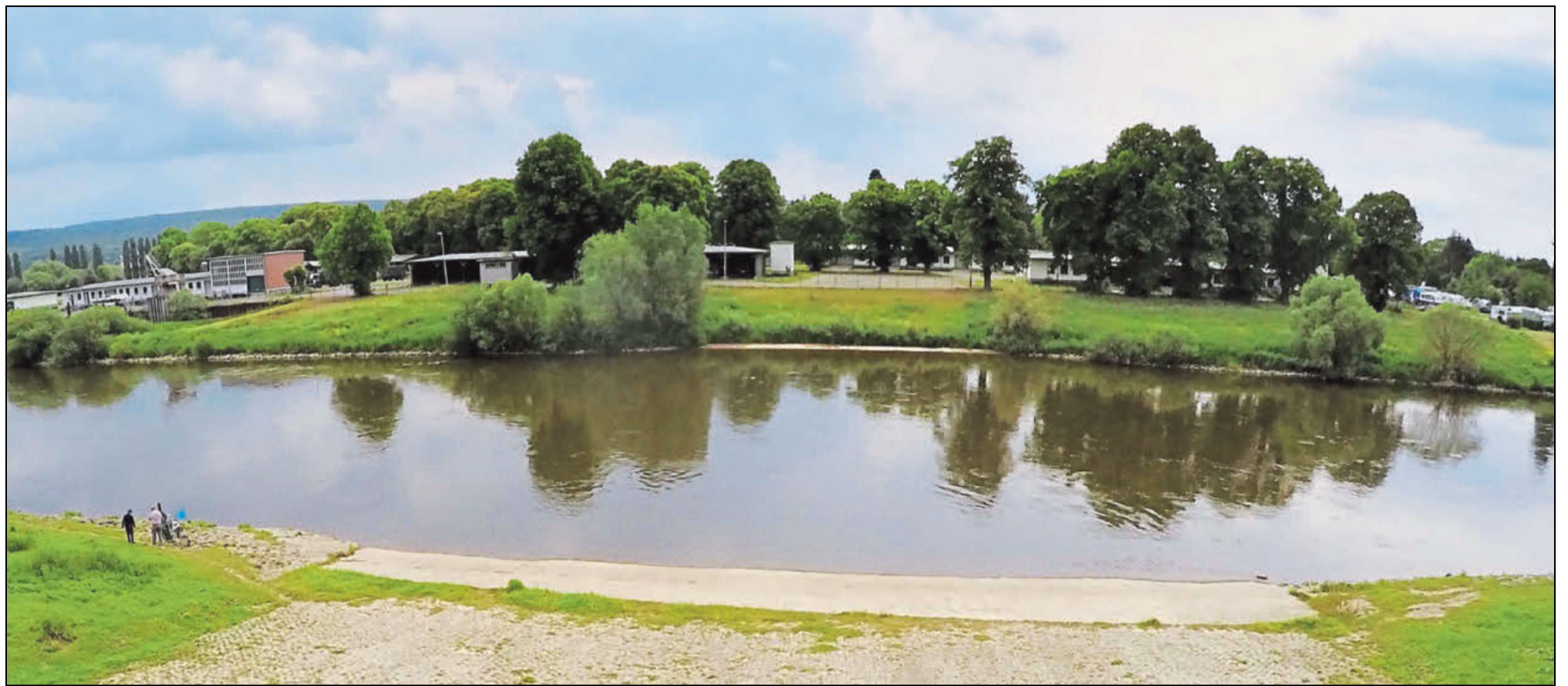
Direkt neben dem Weser-Wohnmobilhafen (rechts) in Höxter liegt das Areal der Bundeswehr – mit Hafenanlage. Der Ortsausschuss begrüßt den Rückbau. Fotos: Harald Iding
