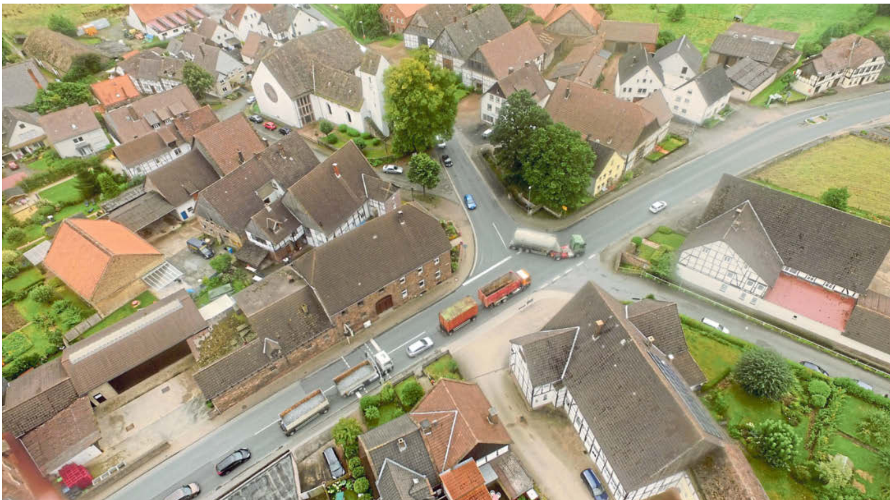
Heutige Situation im Ortskern Godelheim: Die Bundesstraße 83 (von oben) trifft auf die Bundesstraße 64. Dieser Anschlusspunkt wird verschoben.
