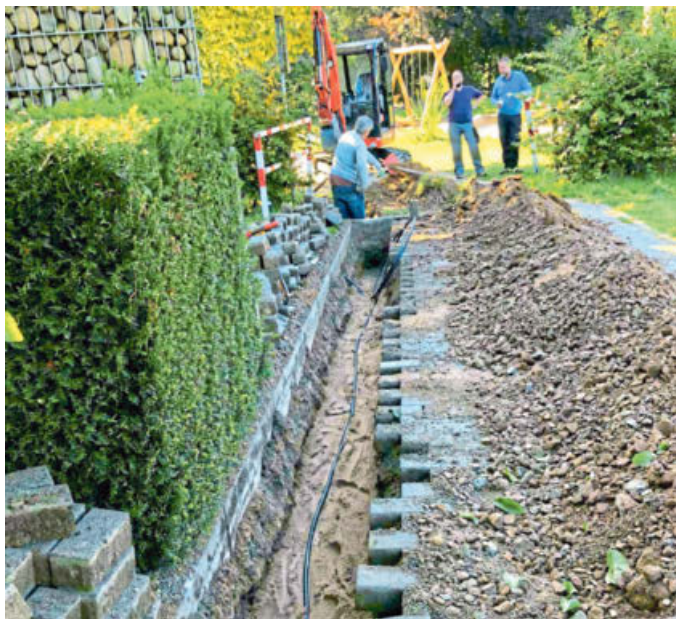
Sinnvoll: Das Kabel für die neue Beleuchtung. FOTO: RAINER SCHWIETE
