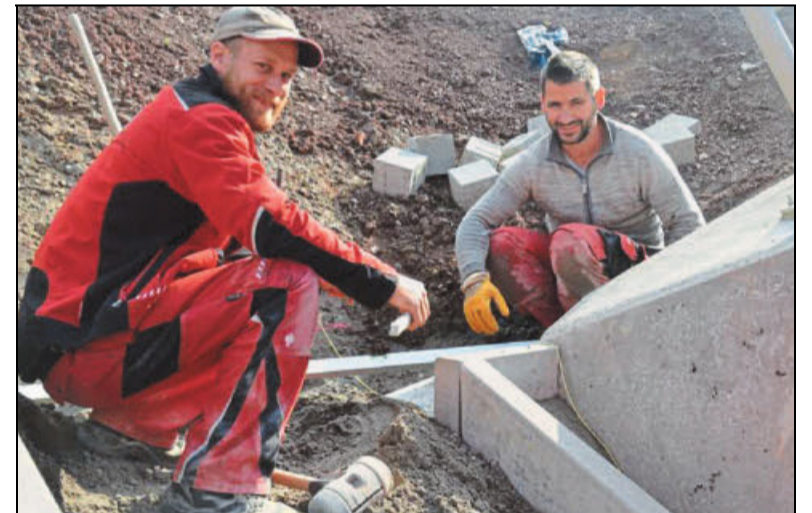
Marcel Crois (links) und Helder Figuerdieo bereiten die Pflasterung von Regenabläuffröhen an der neuen Brücke vor.
