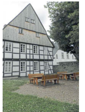
Umfangreich saniert: Der Wiemers-Meyersche Hof im Ortskern von Ottbergen.
