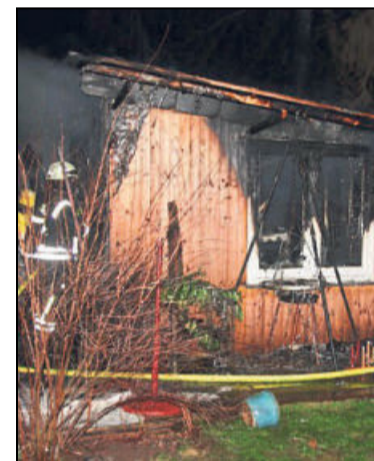
Von der Gartenhütten stehen nur noch Reste.
