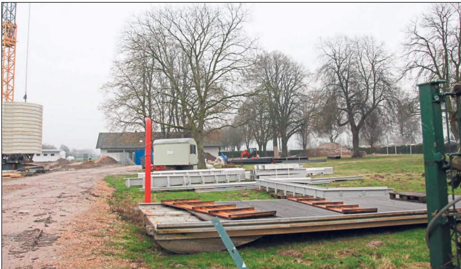
Die große Liegewiese dient zurzeit als Baumaterialien-Lagerplatz. Spielgeräte und Bänke sind abgebaut. Das Außengelände des Höxter-
