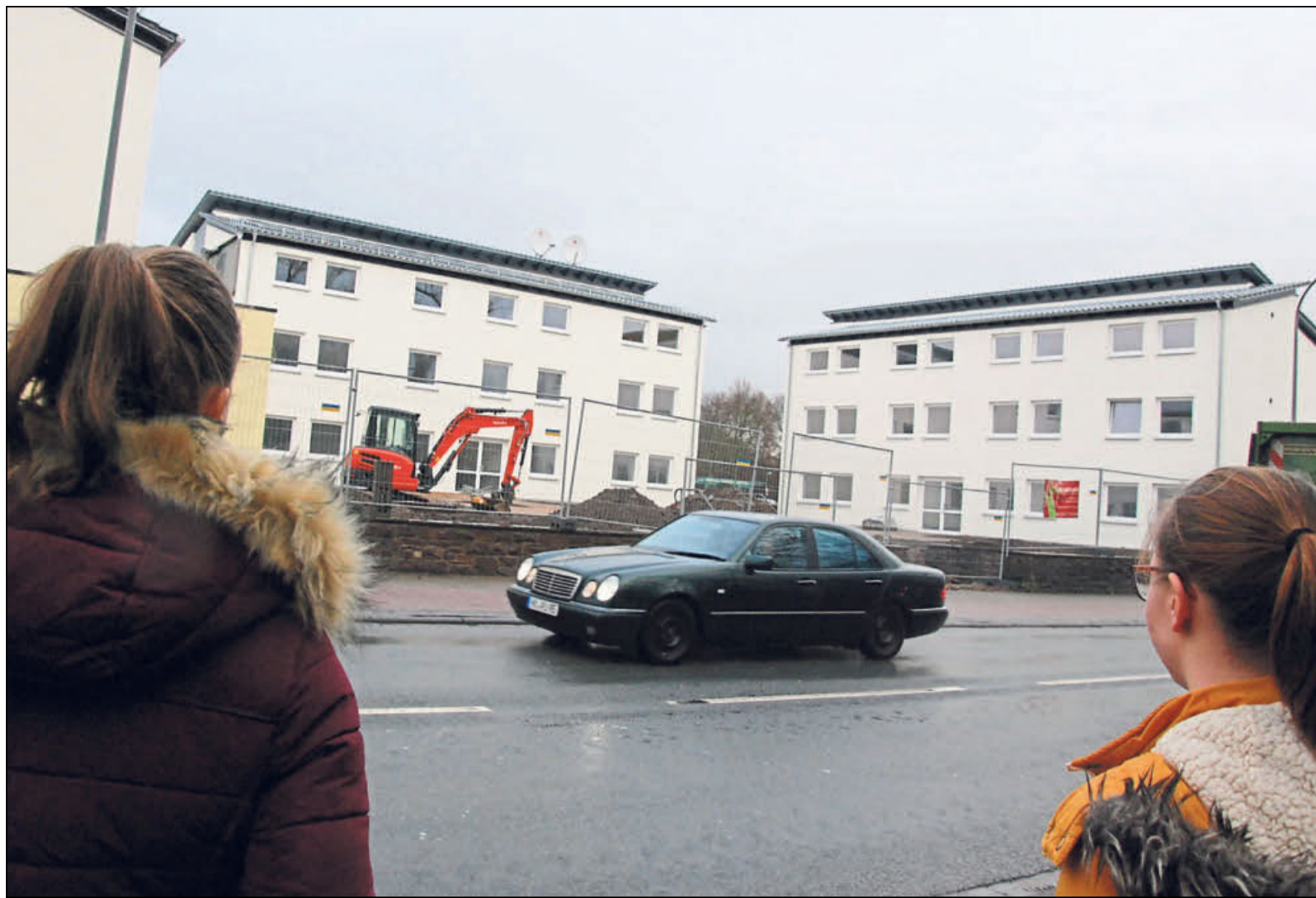
Die an der viel befahrenen L755 (Lütmarser Straße) in Höxter neu gebauten Flüchtlingsunterkünfte sind fast fertig. In Kürze werden die Möbel angeliefert. In einem Haus sind die Handwerker noch einige Zeit mit dem Ausbau beschäftigt. Fotos: Michael Robrecht
