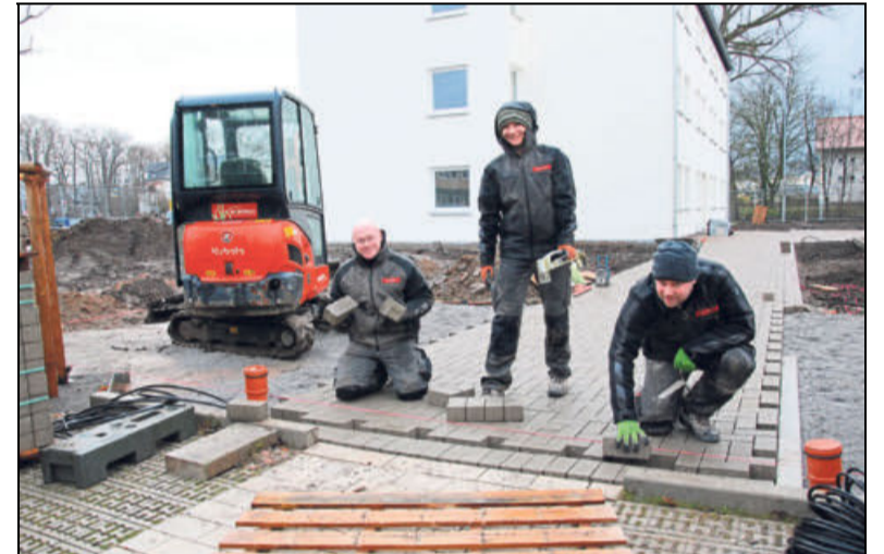
Die Zuwegungen werden gepflastert: Marco Heyder, Judith-Maria Hendricks und Dominic Tölle (Biberbau) arbeiten bei Schneereggen.
