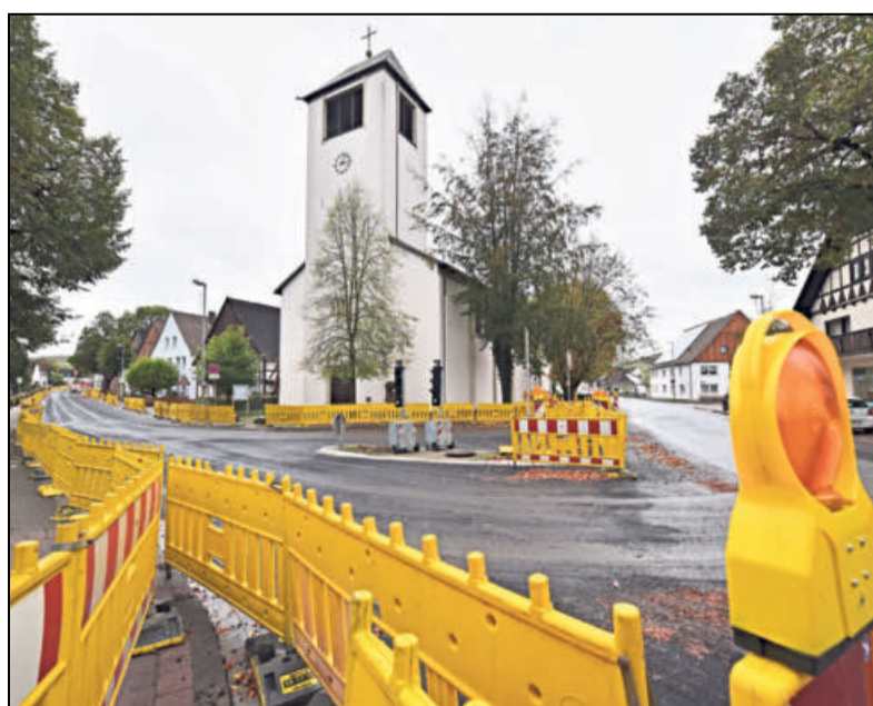
Die Vollsperrung der Landesstraße 890 in Ovenhausen soll am Freitag aufgehoben werden. Sie war zwei Monate gesperrt. Foto: Iding
