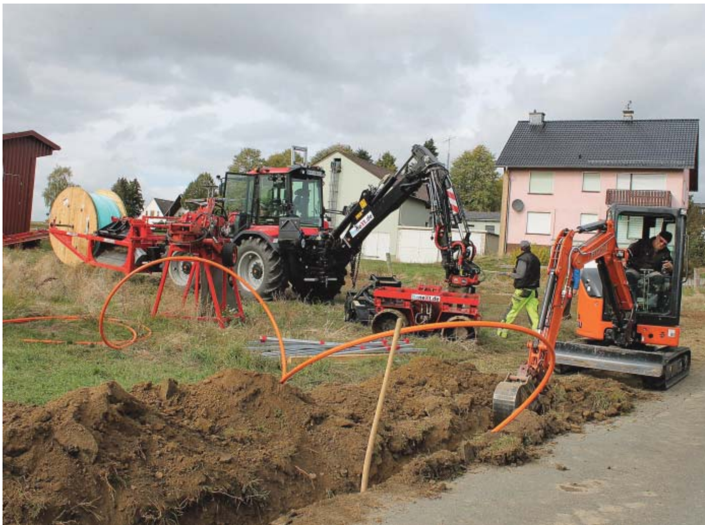
Schneller Kabelpflug: Hier ist das moderne Gefährt der Firma Sewikom bei Auenhausen im Einsatz. Es kann in einem Arbeitsgang die Erde öffnen, das Leerrohr einlegen und sofort wieder alles zuwalzen. Im Vordergrund erkennbar ist der klassische Tiefbau. FOTOS: MANUELA PULS
