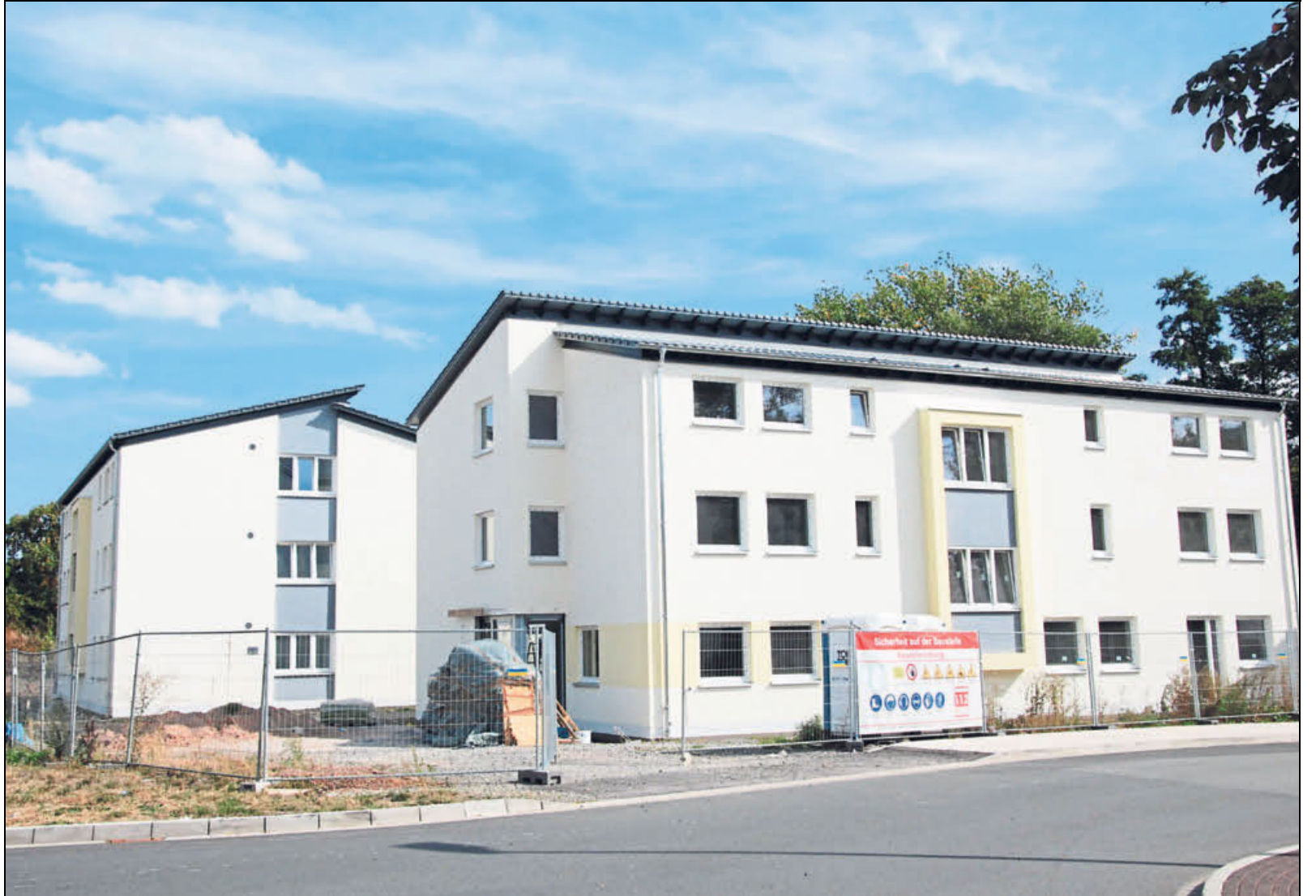
Die Neubauten in der Lütmarser Straße sind fast fertig. In die drei Häuser mit insgesamt 75 Plätzen ziehen demnächst 51 Menschen
