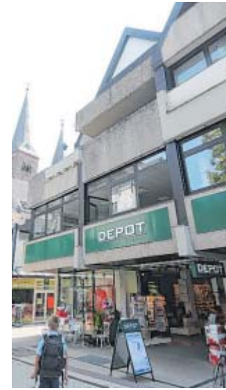
Markt 6: Im zweiten Obergeschoss finden derzeit noch Umbauarbeiten statt. FOTO: S. FLÖRKE
