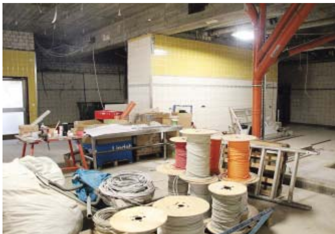
Ehemalige Krankenhausküche: Die gekachelten Wände aus den 70er Jahren erinnern an die frühere Nutzung.
