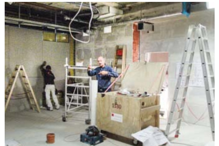
Umbau schreitet voran: Technischer Leiter Johannes Brune erläutert die Planung.
