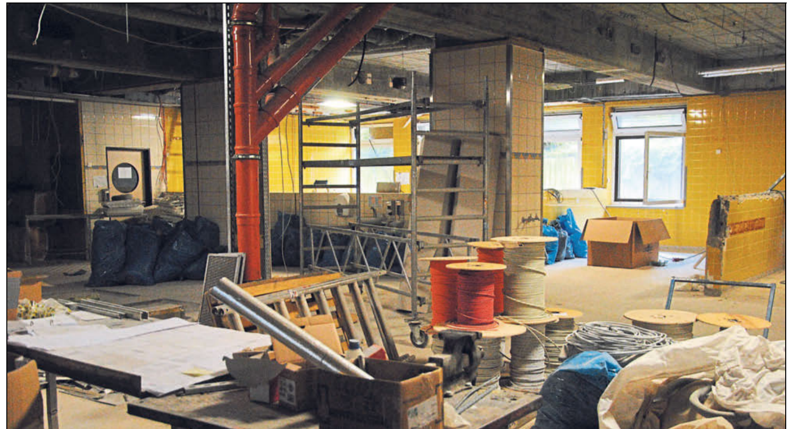
Kaum etwas erinnert noch daran, dass dieser Raum die Küche des St.-Ansgar-Krankenhauses war.
