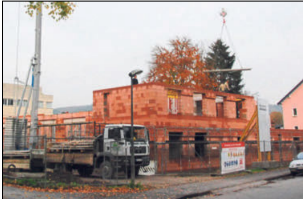
In Höxters Luisenstraße wird eine neue, größere Rettungswache auf dem alten Hallenbadgelände gebaut.
