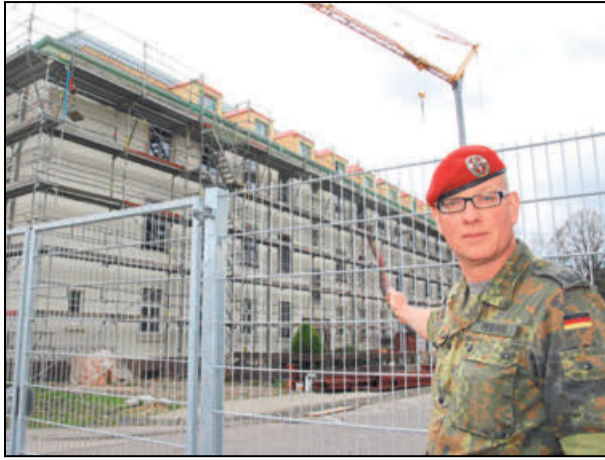
Oberstleutnant Ralf Pfeffer zeigt die Millionenbaustelle Kaserne Höxter. Der Bund saniert die 30er-Jahre-Blocks.
