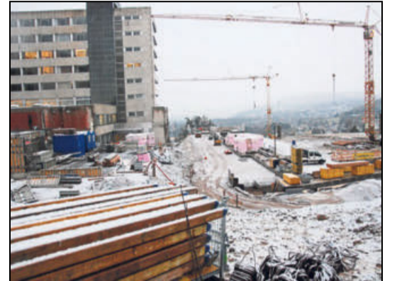
Für 25 Millionen Euro baut der Asklepios Konzern die WBK neu; die Altbauten verschwinden.
