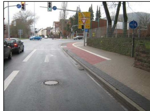
Abb. 29: Nicht abgesenkter Bord bei beginnender Radverkehrsanlage
