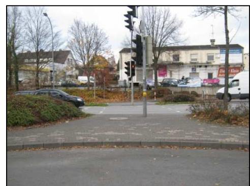
Abb. 39: Albaxer Str., fehlende Bordabsenkung
