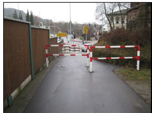
Abb. 59: Zu geringe Einfahrbreite der Umlaufsperrung
