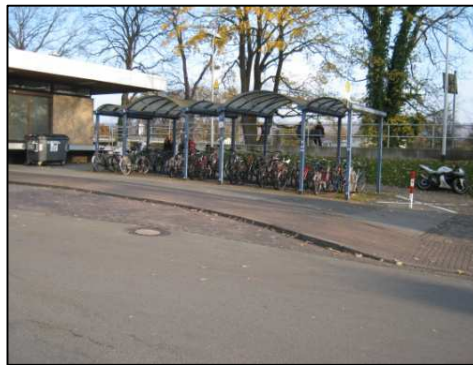
Abb. 81: Überdachte Abstellanlage am Bahnhof
