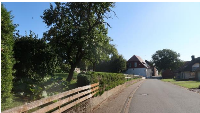
Blick von Westen auf die Mauer im Süden der Teilfläche (Saatzweg).
