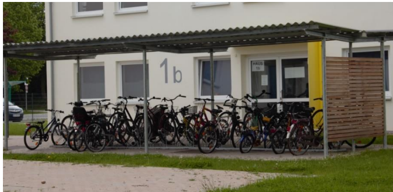
● Abbildung 66: Witterungsschutz vorhanden, jedoch nur Vorderradhalterung (Mai 2021) 112
